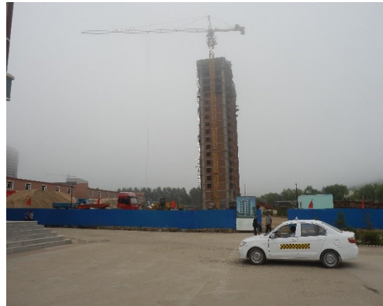
「戦闘」期間中のビル工事 (いずれも 2016年8月、羅先市近郊)
