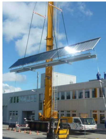
ゼンダー社の塗装工程に導入された太陽熱パネル(写真はリッターXLソーラー社提供)
